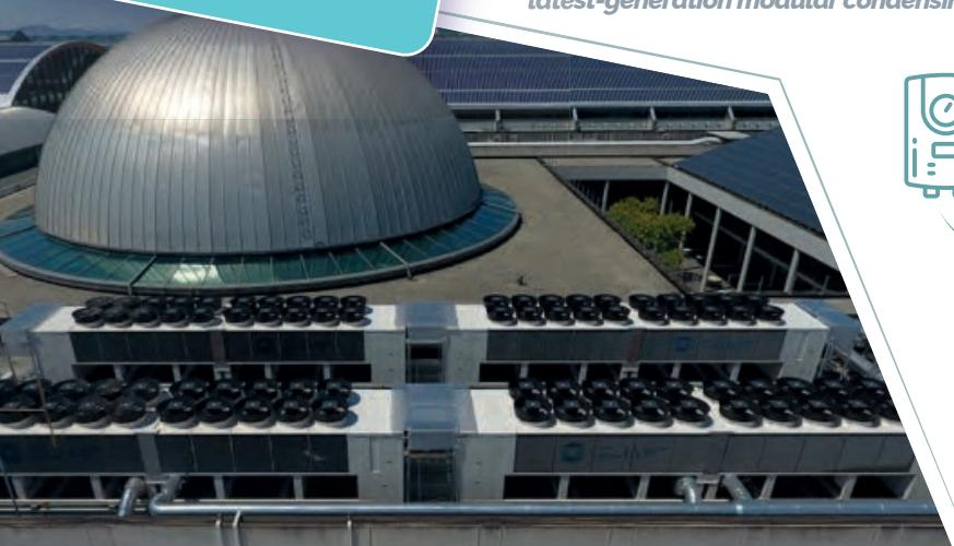
Il Condizionamento ed il riscaldamento del quartiere fieristico sono ottenuti con un impianto di pompa di calore costituito da 32 compressori con tecnologia inverter per una potenza massima di 1600 Kw, installato sopra la hall centrale che consente un notevole abbattimento dei consumi energetici rispetto ai sistemi tradizionali, tramite un impianto composto da due gruppi frigoriferi centrifughi dotato di torri
