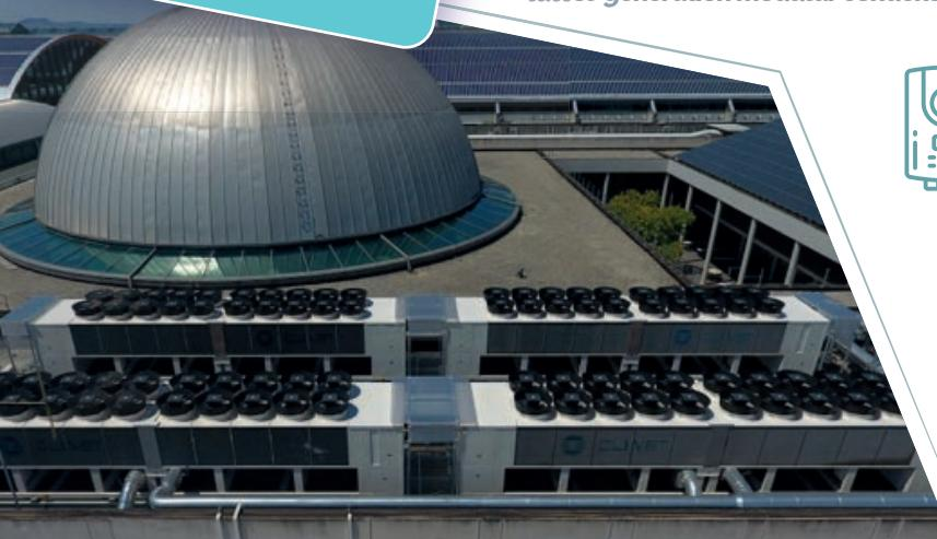
Il Condizionamento ed il riscaldamento del quartiere fieristico di Rimini sono ottenuti con un impianto di pompa di calore costituito da 32 compressori con tecnologia inverter per una potenza massima di 1600 Kw, installato sopra la hall centrale che consente un notevole abbattimento dei consumi energetici rispetto ai sistemi tradizionali, tramite un impianto composto da due gruppi frigoriferi centrifughi dotato di torri
